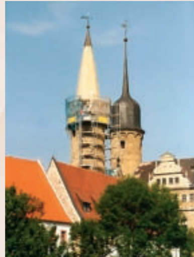
Sanierungsarbeiten am Süd-Ostturm
